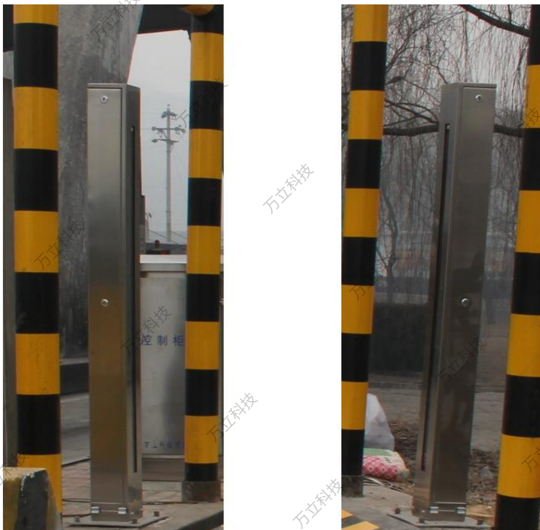
图 4-5 车辆分离器(光幕)现场图
